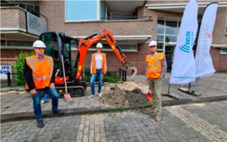
De graafwerkzaamheden kregen hiermee een officieel tintje
